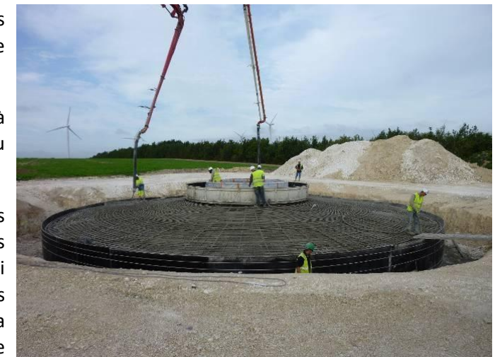
Figure 28. Construction d'une fondation
