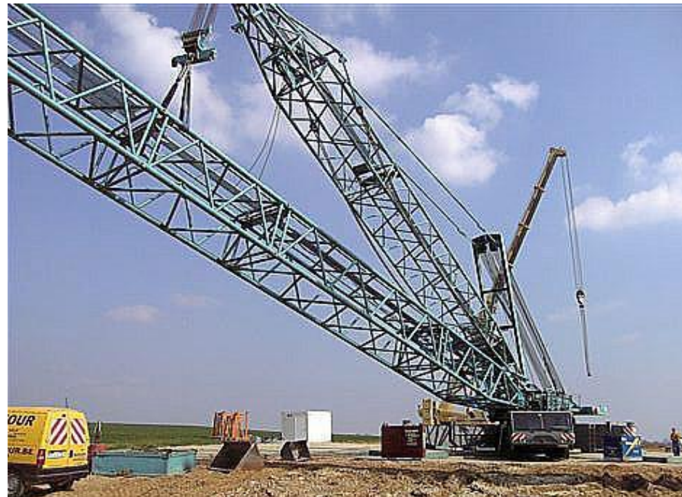
Figure 19. Grue de levage sur une plateforme
