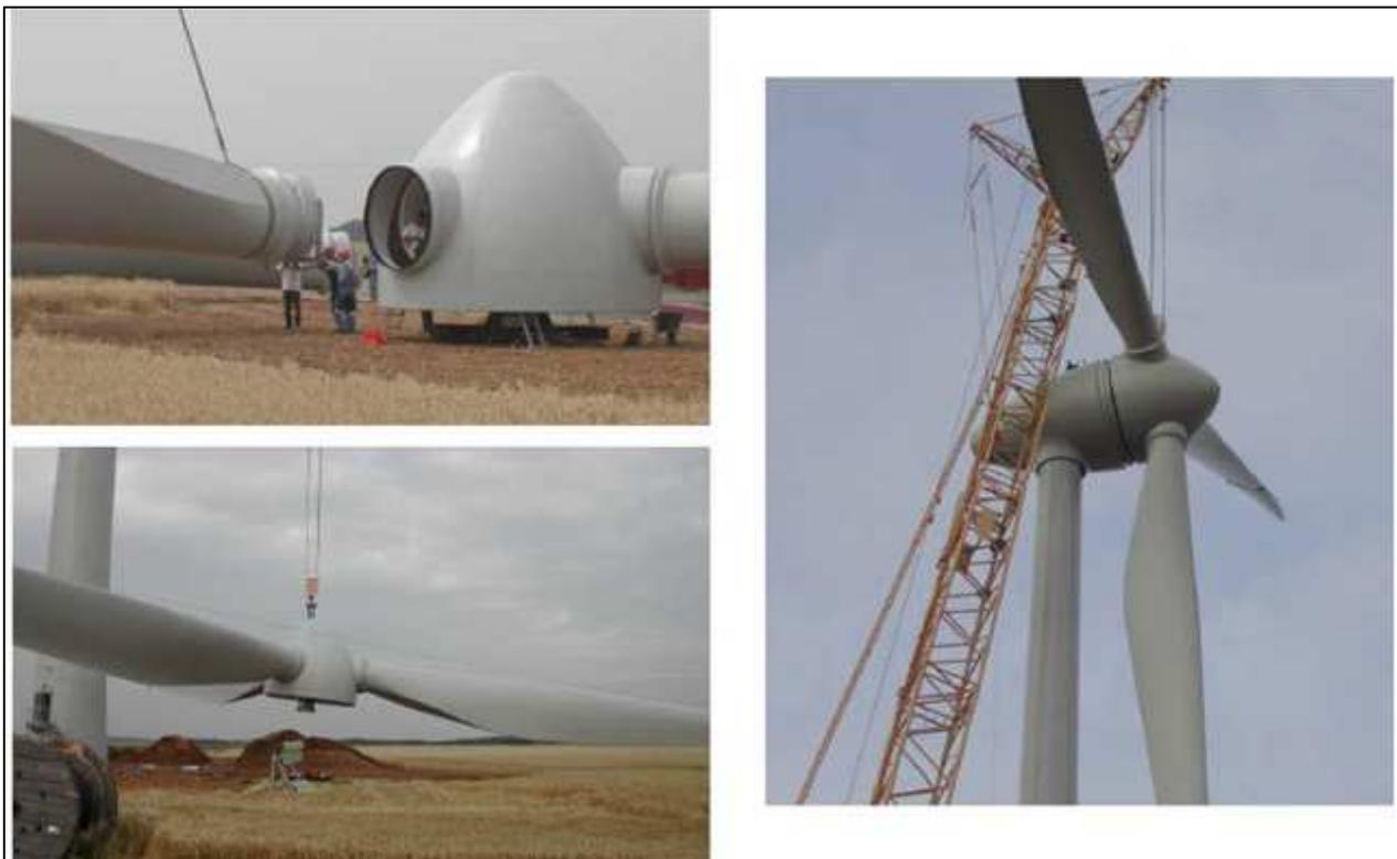
**Figure 15 : Assemblage et montage d'un rotor ENERCON**
