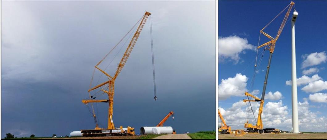
**Figure 19 : Exemple de montage des éoliennes (source : BURGEAP)**
