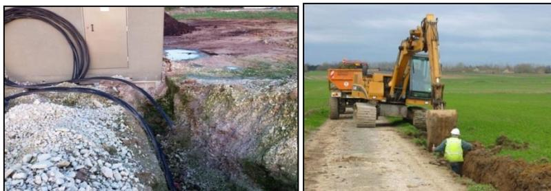
**Figure 10 : Exemple de tranchées pour le passage des câbles électriques**
