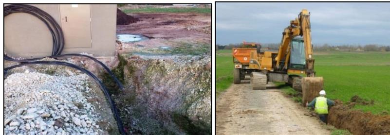
Figure 12 : Exemple de tranchées pour le passage des câbles électriques
